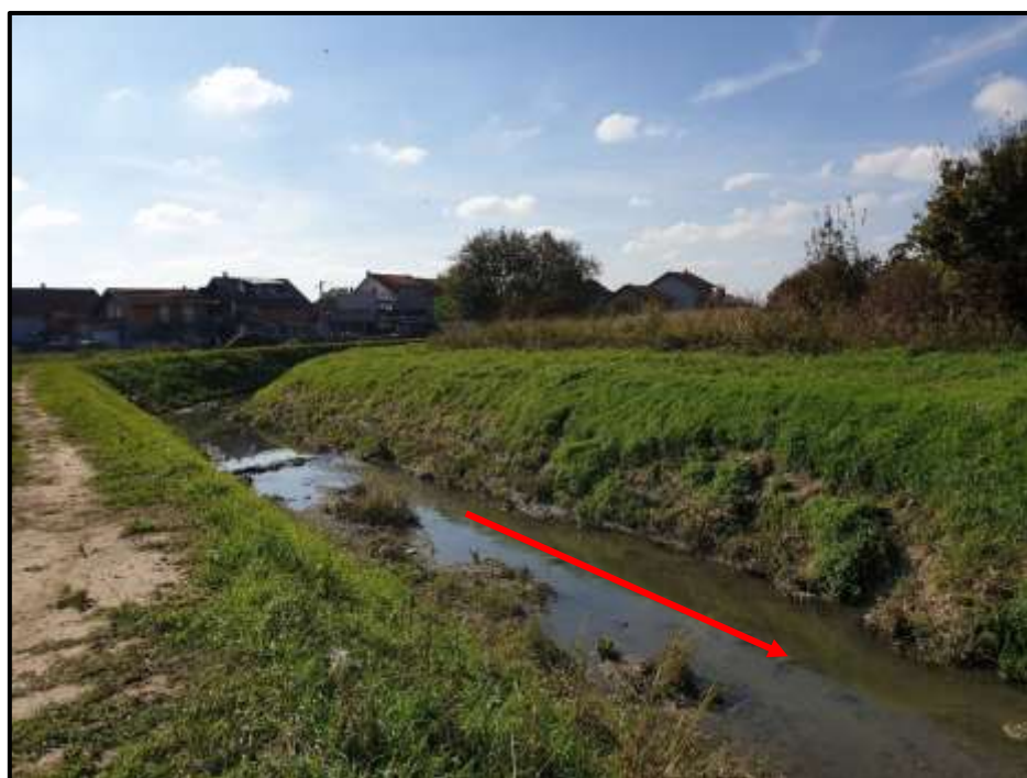
Slika 2.1-4. Nanosi u koritu potoka Vuger i pojava odrona na lijevoj obali na dionici nizvodno od stac. km 1+200,00 te zemljani put duž desne obale potoka, s označenim smjerom tečenja (izvor: Viacon, 2019. )
