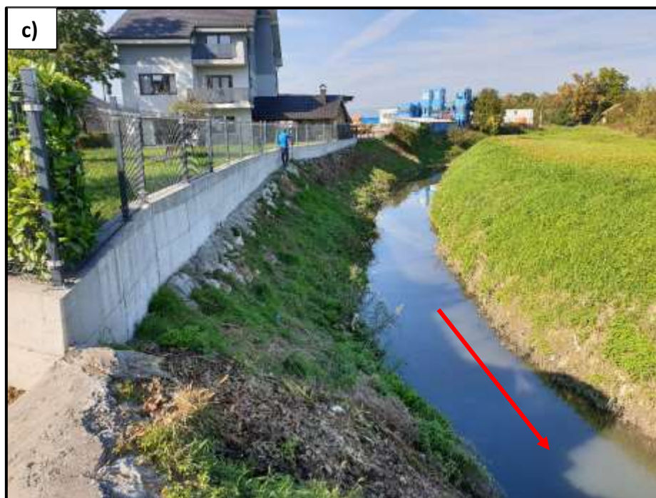
Slika 2.1-3. Dionica potoka Vuger nizvodno od mosta u stac. km 1+403,00, s označenim smjerom tečenja: a) obraslo korito i nanosi u koritu neposredno nizvodno od mosta, b) grmljem obrasla desna obala potoka Vuger uz ograđene privatne parcele uzvodno od stac. km 1+340,00, c) postojeći AB parapetni zidovi na dionici stac. km 1+190 do km 1+340,00 (izvor: Viacon, 2019. )
